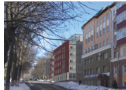
В портфолио бюро «Архиплан» попали самые, пожалуй, интересные здания в районе парка Циолковского: «Башни» на Гагарина и два корпуса строящегося на ул. Циолковского «Галилея»
